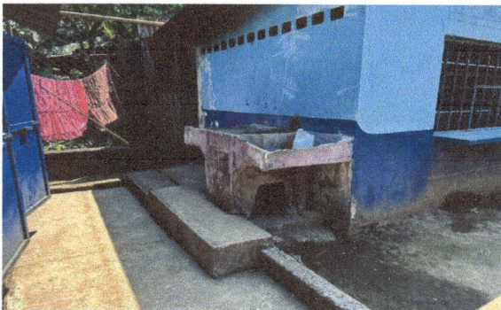
Foto 5: Sustitución de pila de dos lavaderos.
