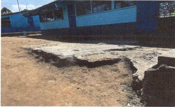
Foto 1: Reparación de torta de piso de concreto de 110 M2.
