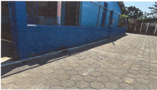
Foto 3: Reparación de muro perimetral dentro.
