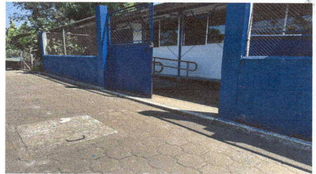
Foto 4: Reparación de muro perimetral por fuera.
